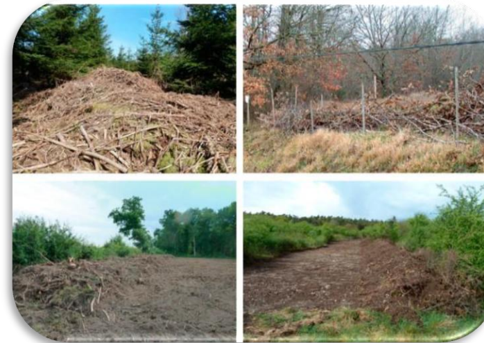
Mise en place de gîtes de replis pour la faune en phase travaux (refuges hors emprises)
