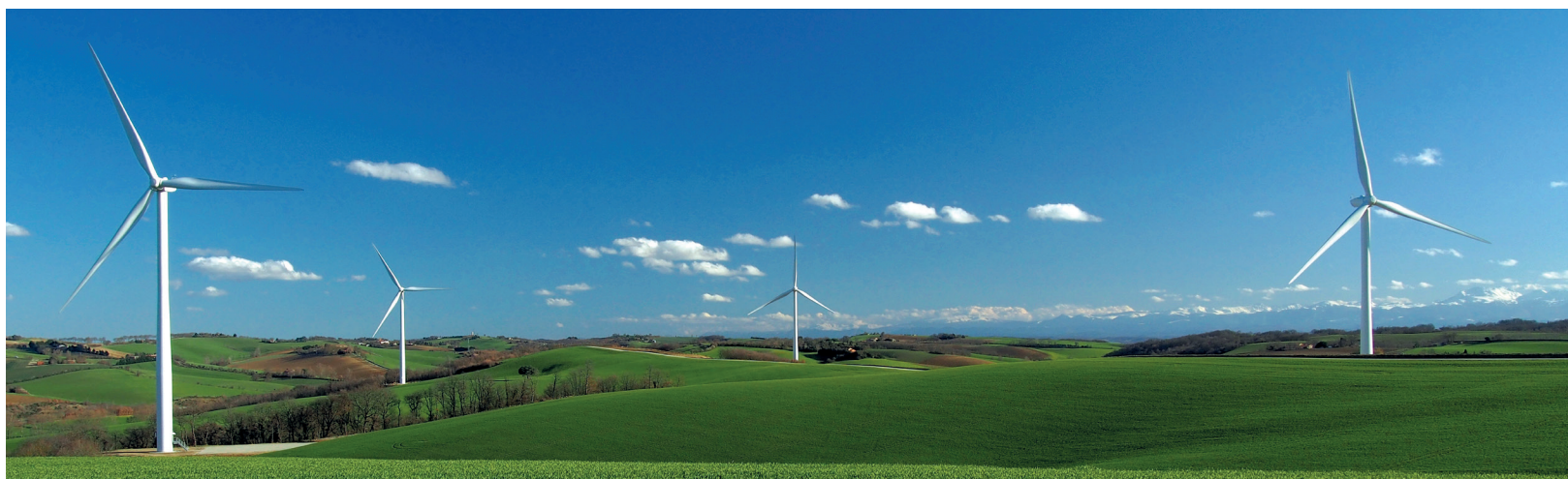
Parc éolien Calmont (Haute-Garonne)
