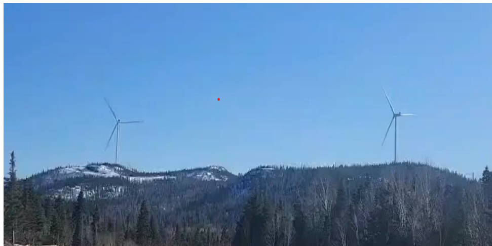
Parc éolien Apuiat, Québec
