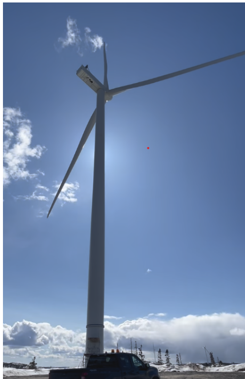
Parc éolien Apuiat, Québec
