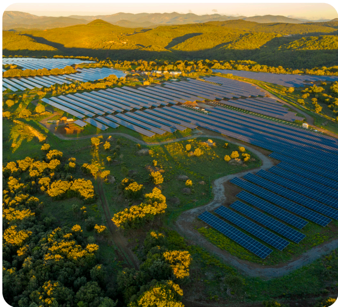
Parc solaire de la Grange du Causse
